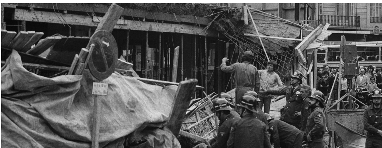
Intervenció de Bombers de Barcelona en l'ensorrament d'un edifici en construcció. 1963. Autoria desconeguda. Arxiu de Bombers de Barcelona
